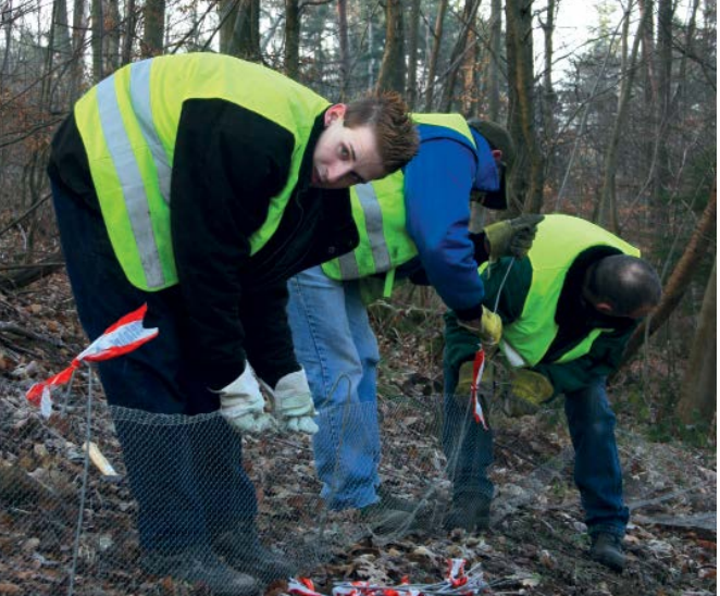
Aufbau Maschendrahtzaun (Foto: M. Bauer)
