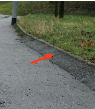
Nachträgliche Asphaltdeckung
