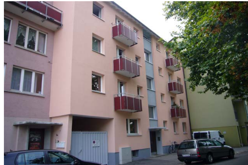
Gebäude nach der Sanierung
