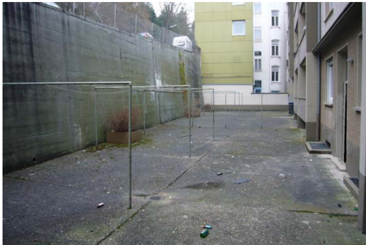
Innenhof vor und nach der Sanierung
