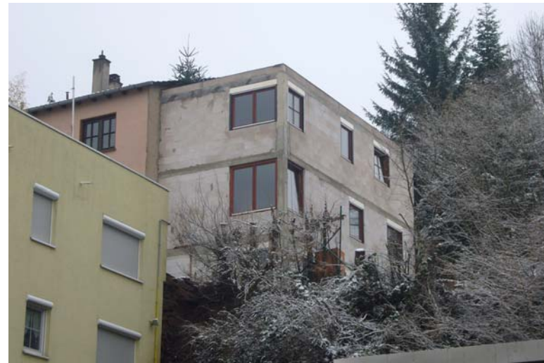
Wohnhauserweiterung während der Bauphase
