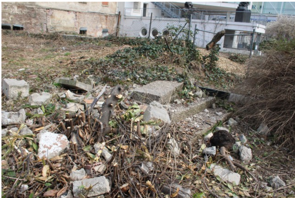
Abbildung 3: Freigeschnittene Reste der ursprünglichen Bebauung
